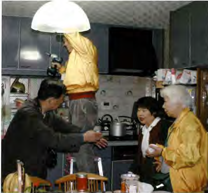
中上・宮本両会員の火災警報器取付作業。広告用に撮影するのは神戸新聞のカメラマン（大原町で）
