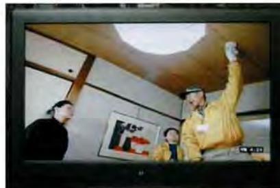
火災警報器の取り付け
