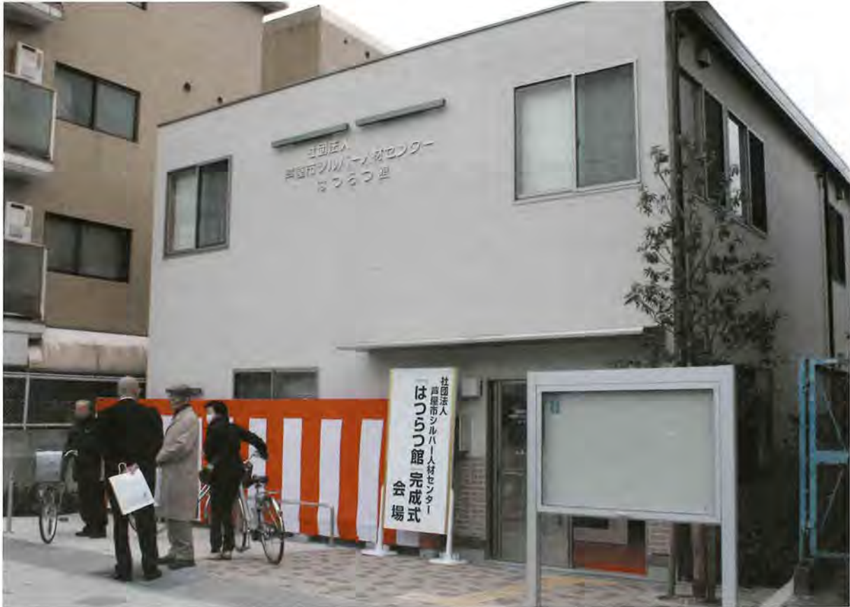
国道2号線沿いにお目見えした新局舎（宮塚町2番2号で）
